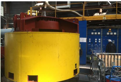
Le GR11, moteur des Costières, constitue un démonstrateur exceptionnel de par sa puissance de 2060 KW, sa vitesse de 600 tr/min et sa tension de 5500 volts. Cet équipement est utilisé pour le pompage d'eau depuis son installation dans les années 60.
