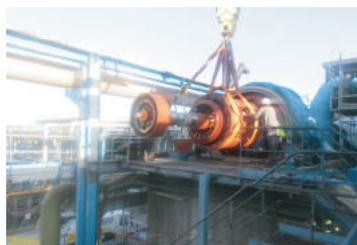
Extraction sur site d'une roue polaire 24 MW 1000 tr/mn
