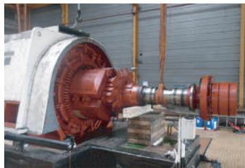
Dépose d'un alternateur 19 500 kVA avec extraction de la roue polaire sur site pour révision en atelier
