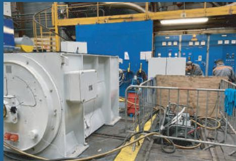
Moteur synchrone 4500kW – 5500V
