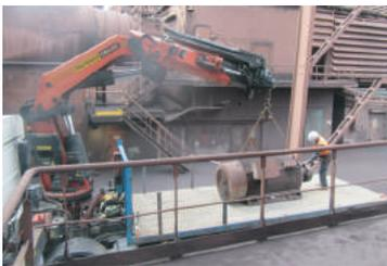
Dépose d'un moteur 800 kW pour révision en atelier
