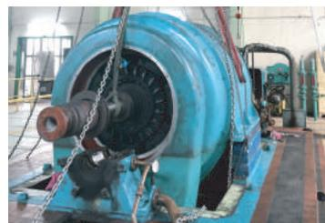
Dépose pour révision en atelier d'un alternateur 5250 kVA - 3000tr/mn
