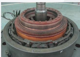
Bobinage sur site du nouveau stator d'excitation avec ancienne virole et pôles neufs
