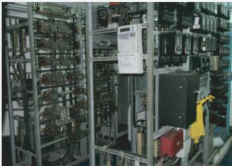
Châssis de commande sur relais à barreaux et relais de protections analogiques
