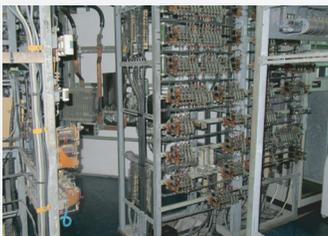
Châssis de relais de protections analogiques
